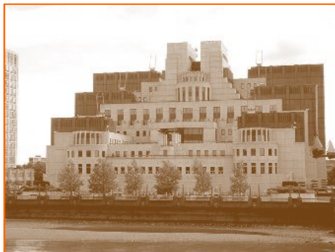
SIS Building à sur la rive sud de la Tamise, au 85, Vauxhall Cross
