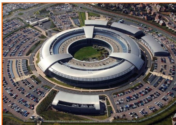
Vue aérienne du « Doughnut », le siège du GCHQ depuis 2006, à Benhall, Cheltenham
